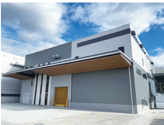
△完成した岡山新工場の外観
